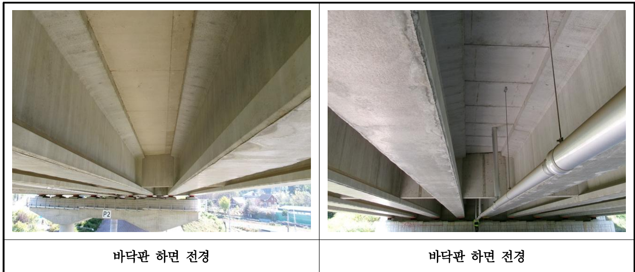
【사진 36.3.2】 바닥판하면 전경
