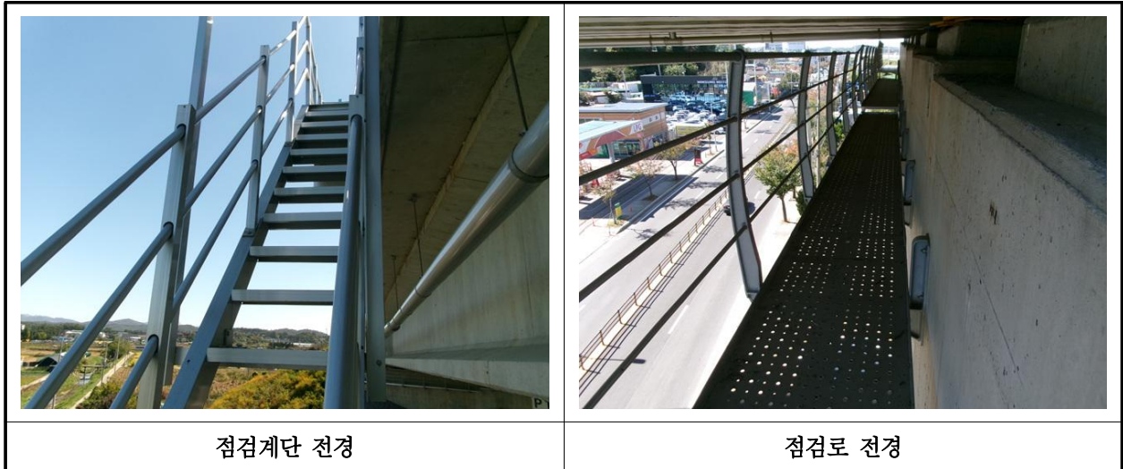
【사진 36.3.25】 교량 점검시설 전경
