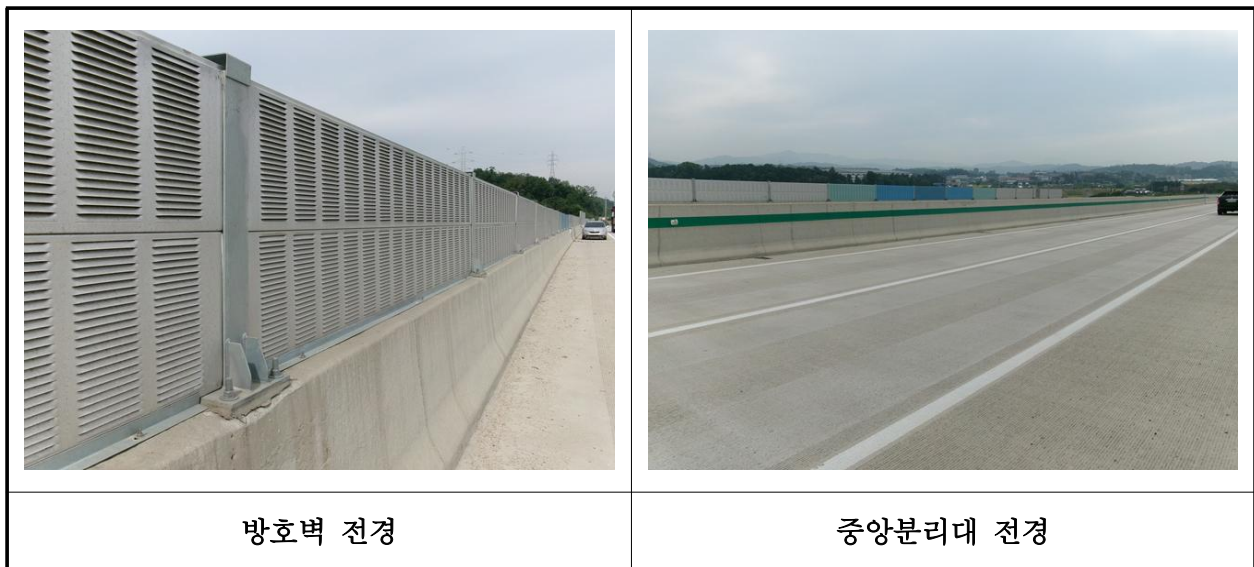
【사진 36.3.23】 방호벽 및 중앙분리대 전경
