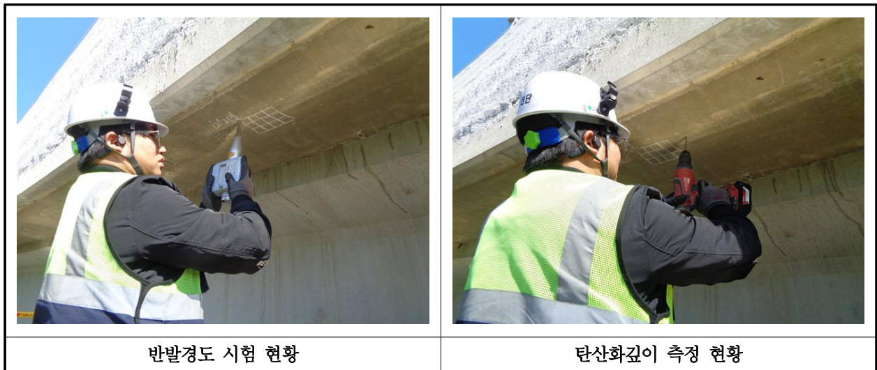
【사진 36.4.1】 콘크리트 내구성조사 현황
