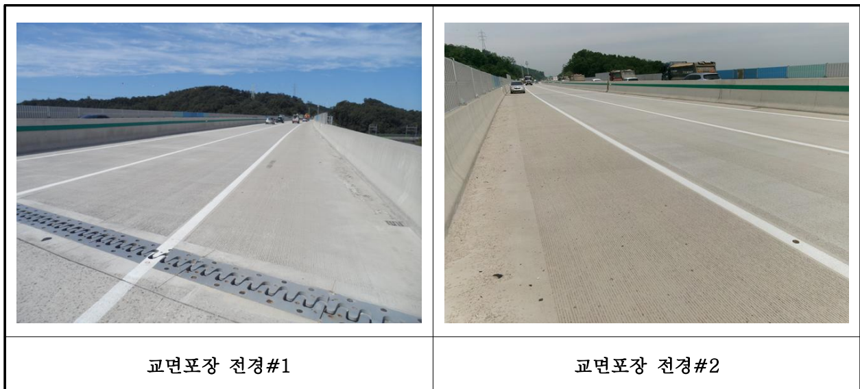
【사진 36.3.19】 교면포장 전경
