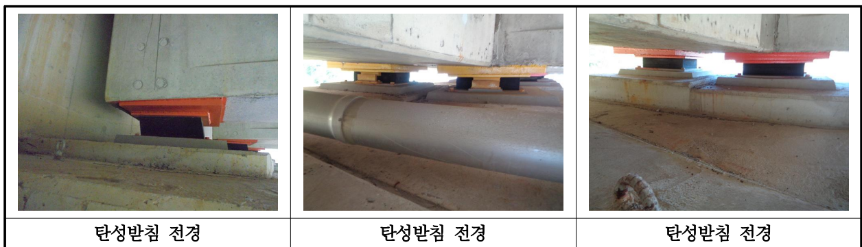
【사진 36.3.12】 교량받침 전경
