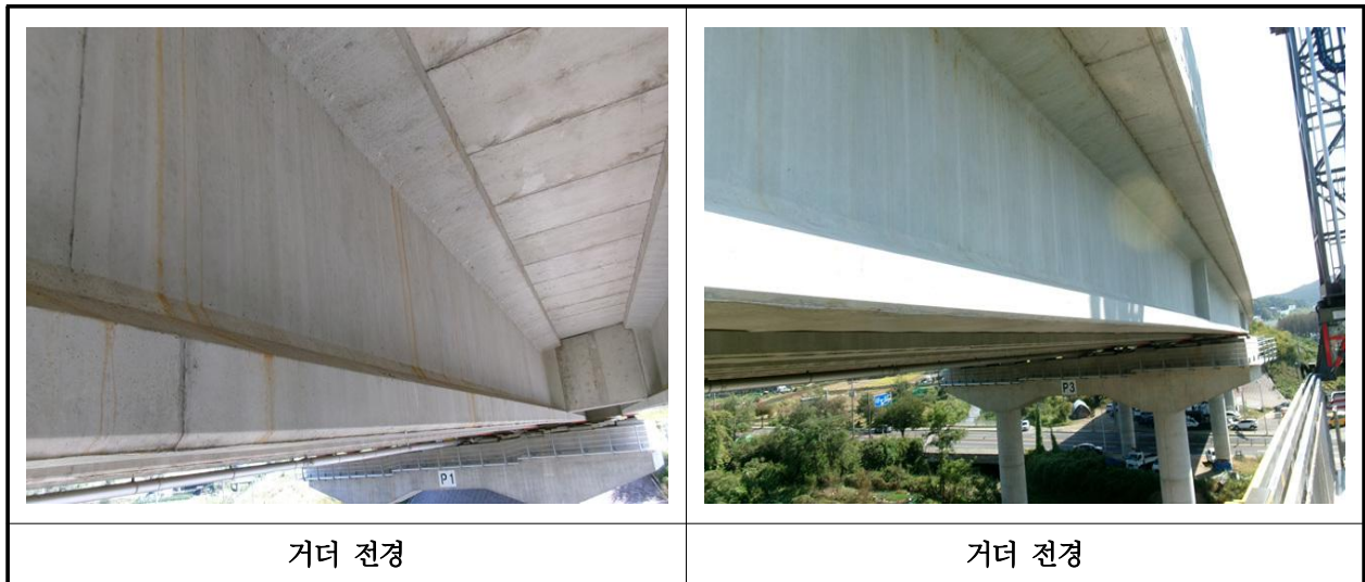
【사진 36.3.4】 거더 전경
